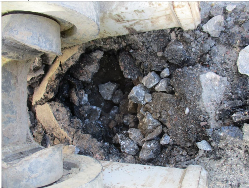
Bild 8. Provpunkt SM 8, stenfyllning under asfalt.
