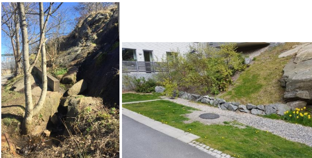
Figur 16. Exempel avskärande åtgärd i form av mur (vänster) och grussträng invid bergsslänten (höger). Foto: Ramboll
