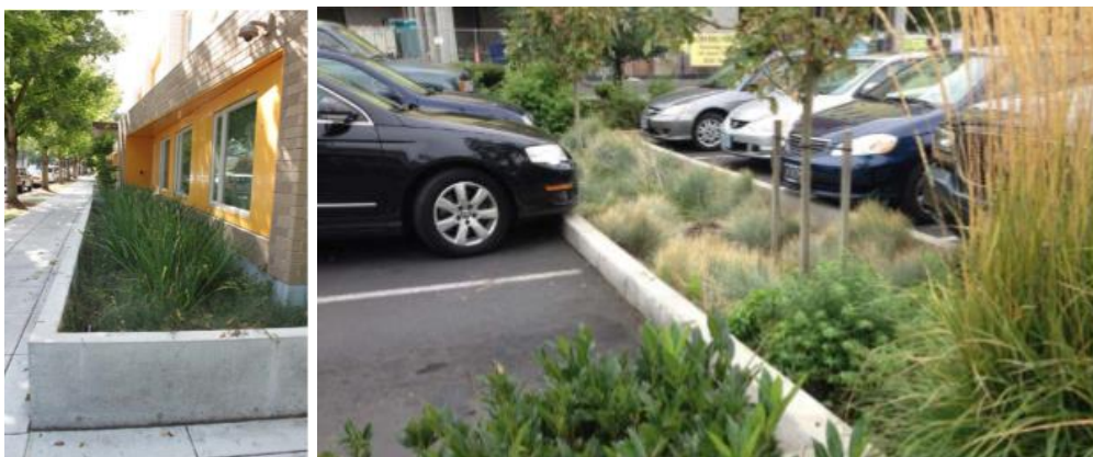
Figur 12. Exempel på nedsänkta växtbäddar, för hantering av takdagvatten till vänster och dagvatten från parkerings- och asfaltsytor till höger. Källa: Anläggningsbeskrivning för nedsänkt växtbädd, Stockholm Vatten och Avfall.
