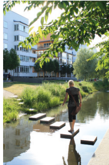
Figur 10: Integrera välfungerande och tåliga system för dagvatten. Utnyttja mark, växtlighet och vattensamlingar för att rena vatten och jämna ut flöden.
