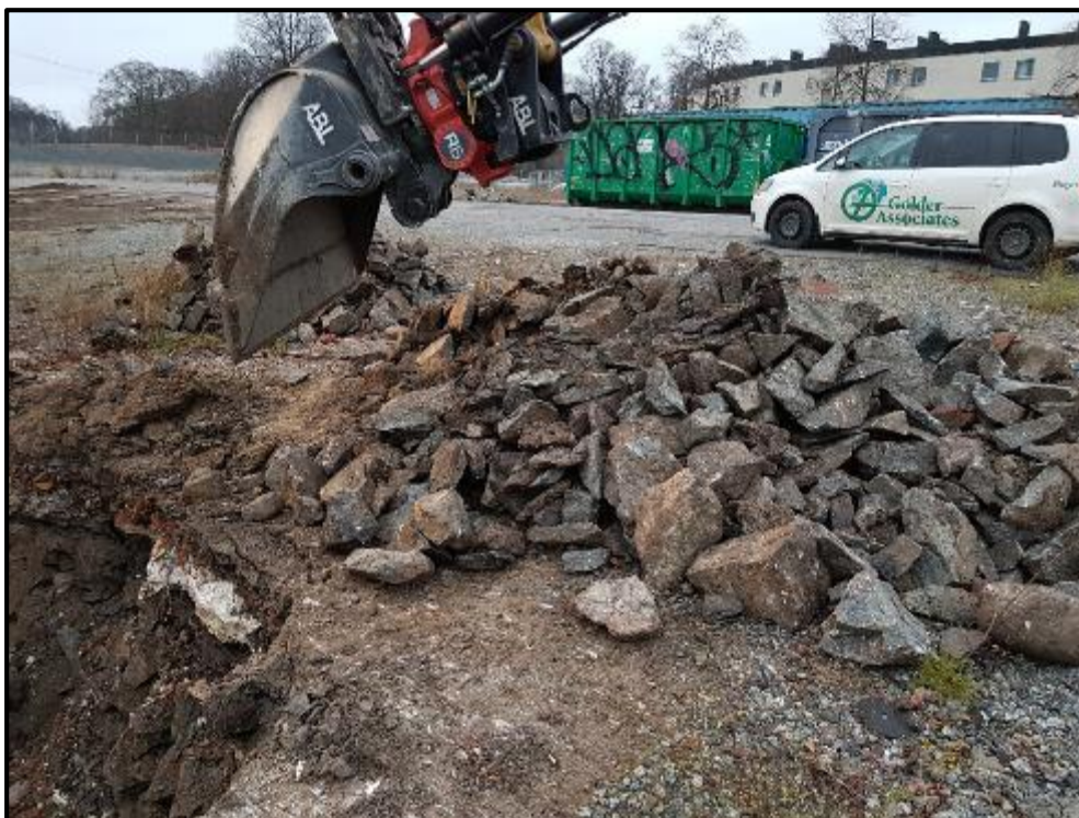
Figur 16: Bilden visar uppschaktad sten från provgrop 17GAPG22..
