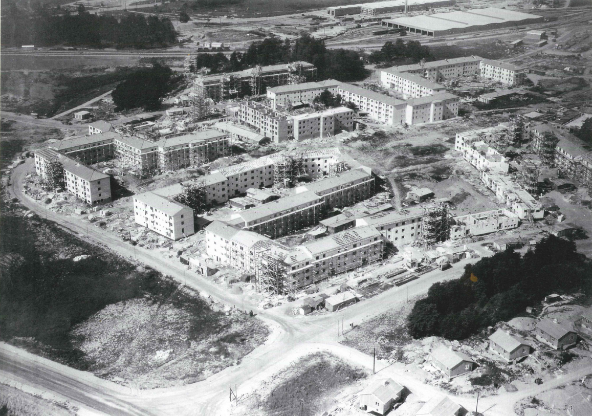
Husen vid korsningen Multrågatan/Solleftegatan under uppbyggnad 1952. I högra hörnet syns Småstugebyråns villor. Källa: Stockholm före miljonprogrammet.
