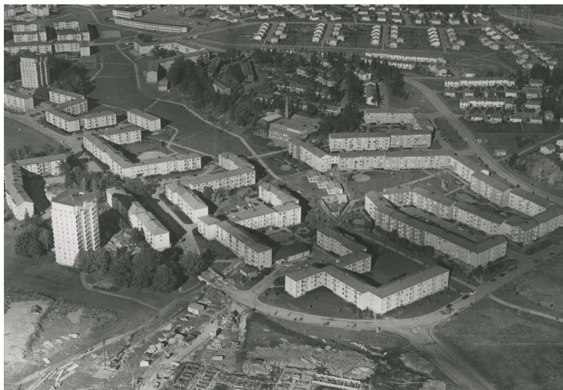
Bilden är från 1957 och visar de färdigbyggda husen längs Multrågatan, Långseleringen och villorna i områdets utkanter. I förgrunden byggarbetsplatsen för Vattenfallshuset. Källa: Stockholms stadsmuseum.
