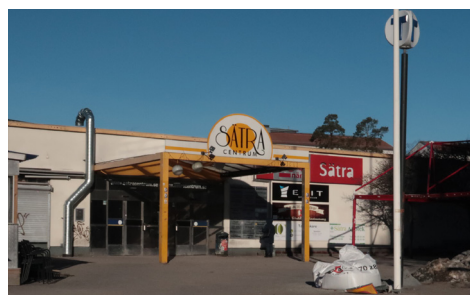
Sydvästra entrén 2007 (källa: TT) och 2019.
