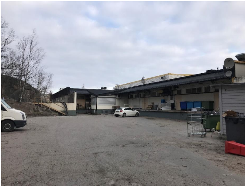
Figur 17 Lastzon söder om centrumbyggnaden, denna bedöms relativt outnyttjad.
