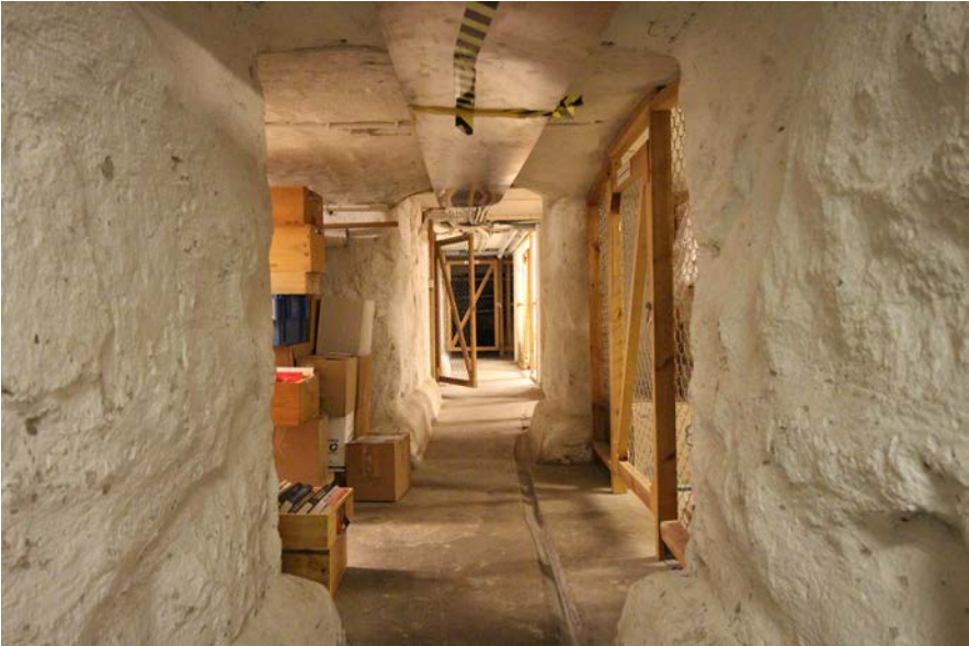
Källarkorridor med förrådsutrymmen på var sida.
