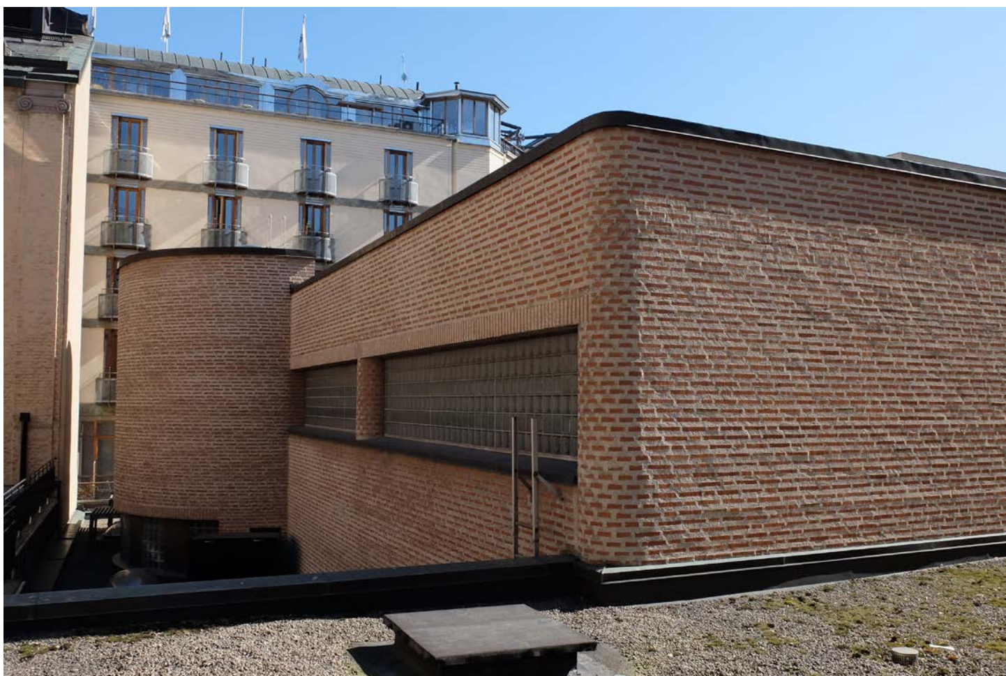
Kyrkosalens överbyggnad i tegel med rundade hörn och detaljer i glasbetong och koppar.
