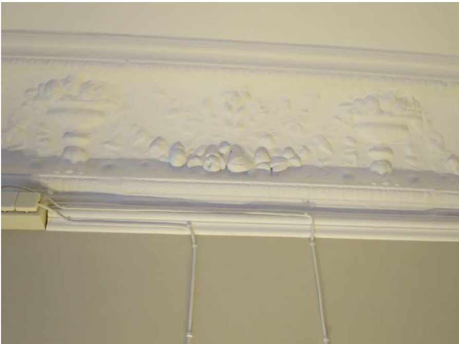
Takstuckatur med flera lager färg som medfört att mönstret nära på försvunnit.
