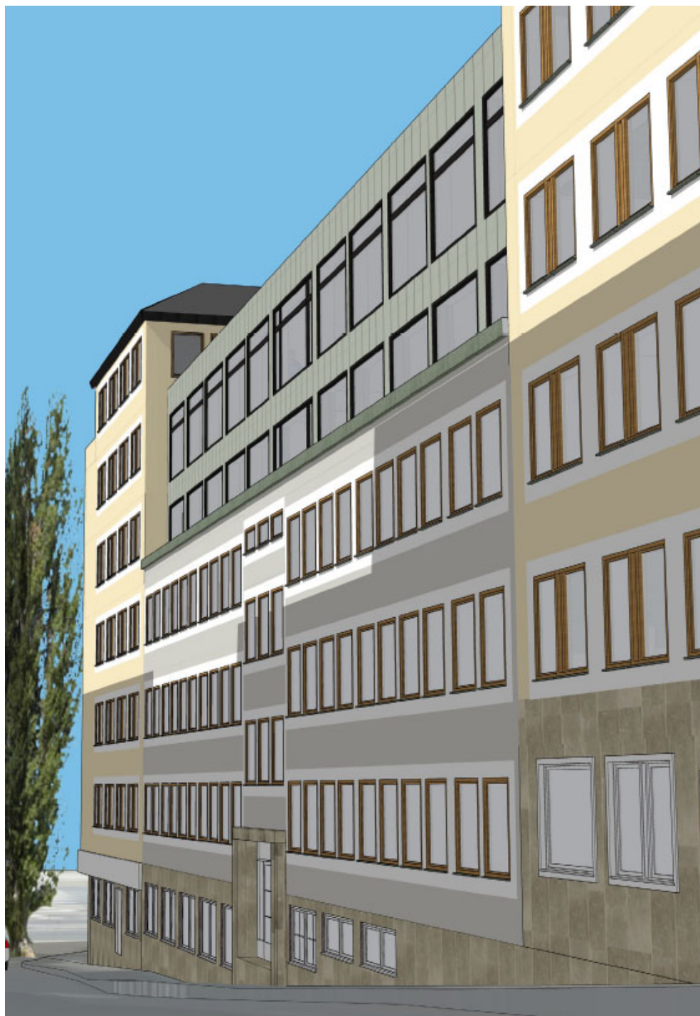
Påbyggnaden är indragen från den befintliga byggnadens fasad med 70 cm. Indragningen är anpassad till fönsterplaceringen på de anslutande byggnadskropparna. Illustrationen är framställd av Thule Fastighetsutveckling.
