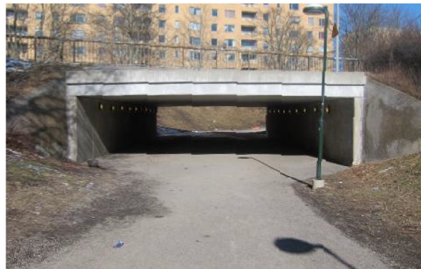
Figur 21. Gångtunnel. Foto Ramboll.
