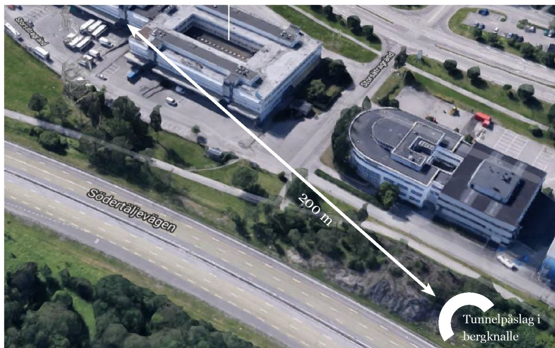
Figur 11: Förbifartens tunnelpåslag i bergknalle 200 m från skolbyggnad (Foto Google)
