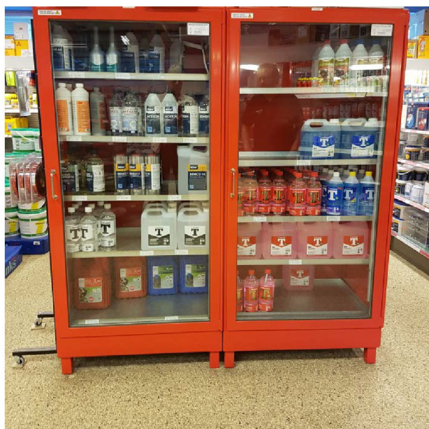
Figur 6: Kemetyl, Alcylat, Målartvätt och Tinner i EI30 skåp
