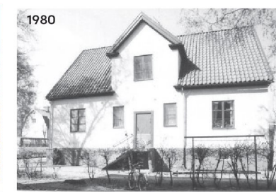
RIVEN OCH ERSATT AV NY BYGGNAD
