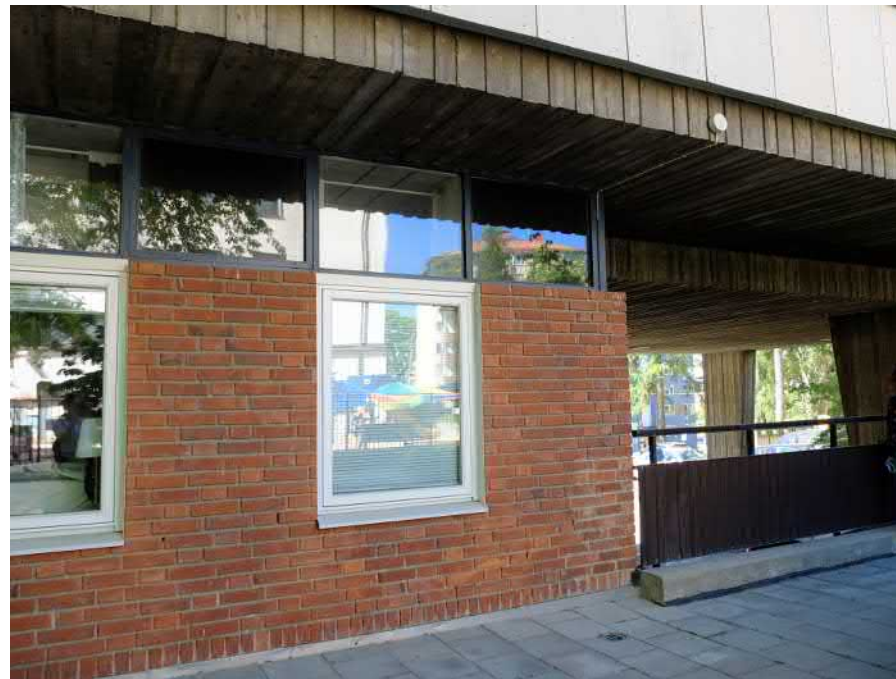
Nya vita aluminiumfönster har tillkommit på både gatu- och gårdsfasad i samband med att bottenvåningen inreddes med två nya bostäder. Räcke i anslutning till det överbyggda garaget öppning är också sekundärt.
