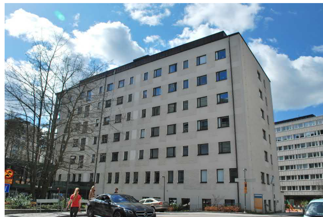
1980-tals tillbyggnaden av det sjukhemmet mot Värtavägen är parallellt placerad med Fyrtalet med gaveln orienterad mot Sandhamnsgatan. Byggnaden består av sju våningar med indragen teknikvåning på taket. Fasaden har en återhållsam karaktär med slätputsad ljus fasad som anpassats till kvarterets 1960-talsbebyggelse.
