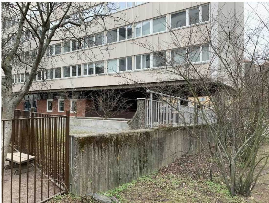
En formgjuten betongmur omgärdar norra gården mot Sandhamnsgatan i norr. Delar av muren kantas av ett sekundärt stålräcke.
