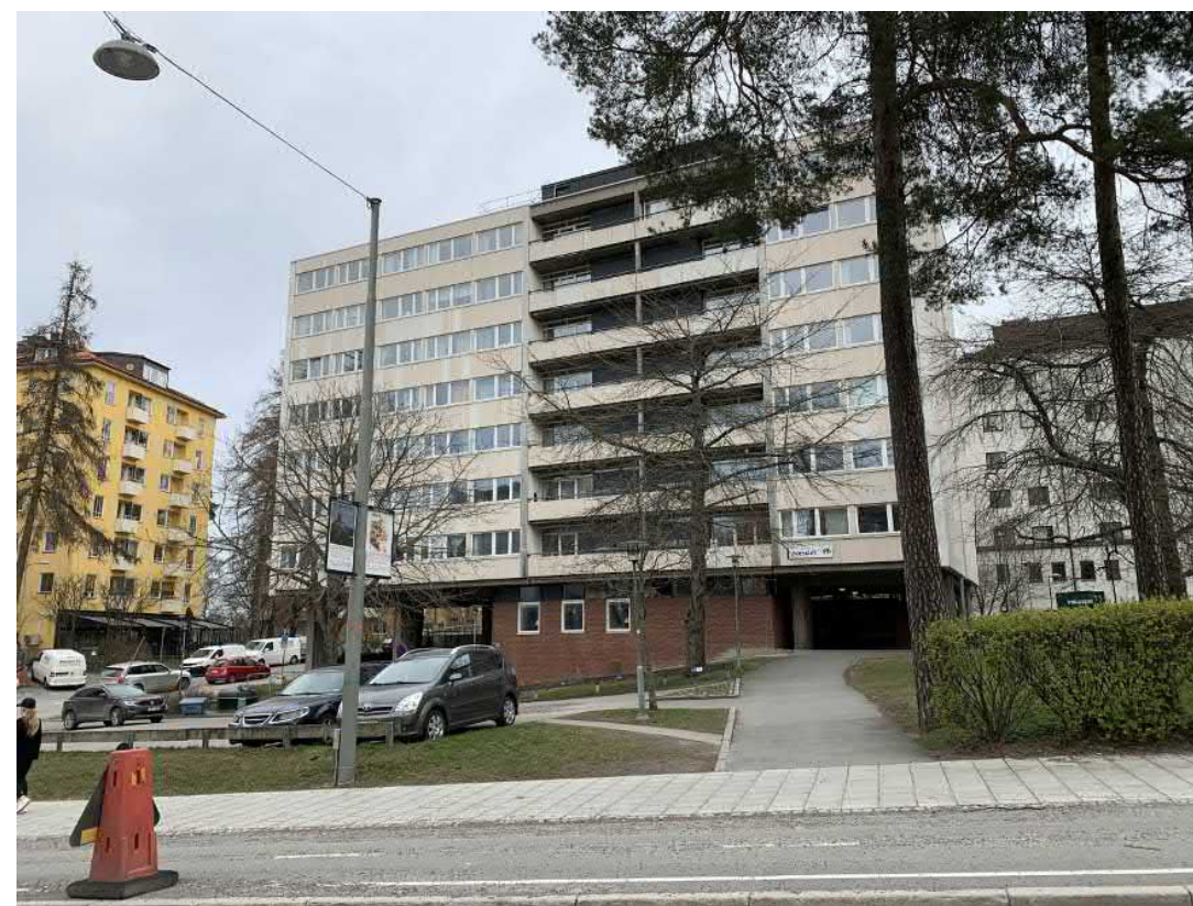
En asfalterad gångväg leder direkt från Värtavägen till huvudentrén. Den tegelklädda bottenvåningen kantas av ursprungliga fönsterband placerade i fasadens överkant. Vita aluminiumfönster har tillkommit i bottenvåningen som påverkat den ursprungliga karaktären negativt.
