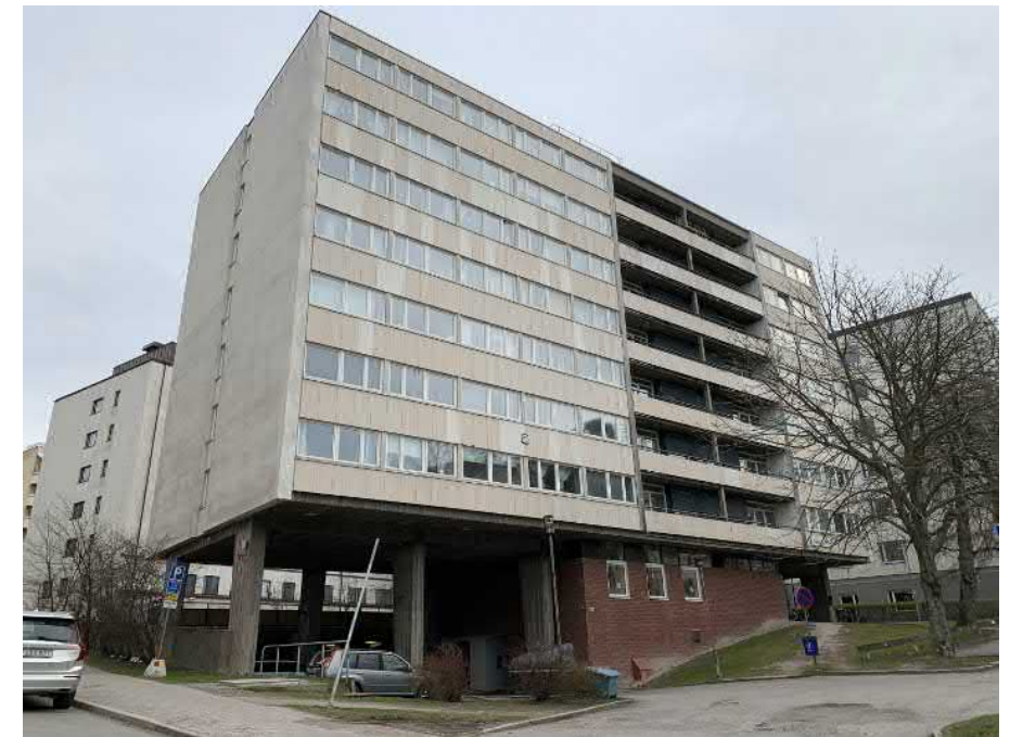
Fasadrenoveringen och tilläggsisoleringen som genomfördes på 1990-talet innebar en ökad tjocklek på 10 cm och att stora delar av det ursprungliga fasadmaterialet samt fönster och dörrar byttes ut i bostadsvåningarna.
