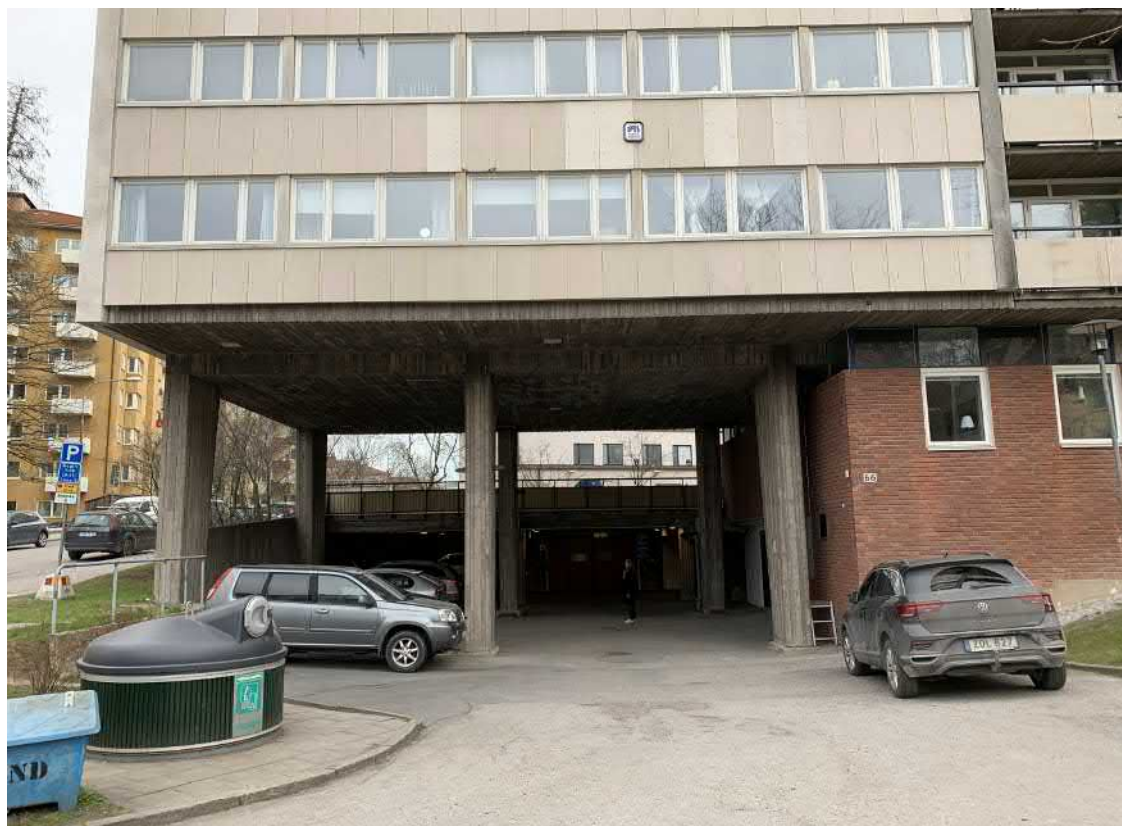
Infart till det överbyggda garaget sker mellan pelarstöden. Både infart och garageytor är asfalterade. Intill garageinfarten finns en mindre gräsyta med växtlighet i form av buskar samt en hårdgjord yta med en sopmollock.
