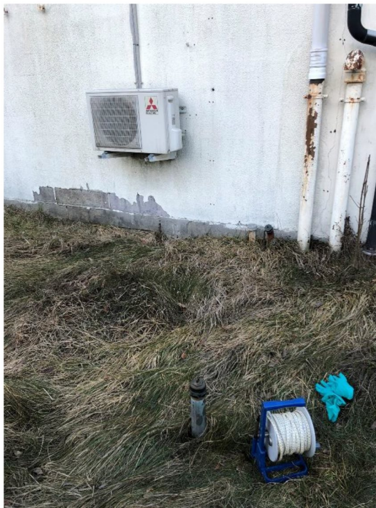
Figur 7 Närbild på "okänt rör" bakom bensinstationen
