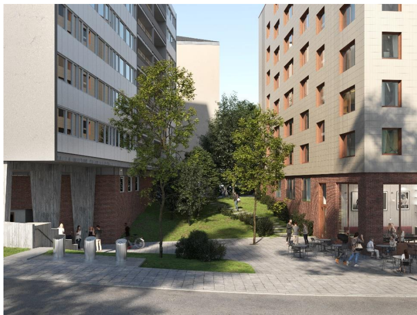
Vy från Sandhammsgatan över den nya gården och torgytan. Bild Sandell Sandberg.
