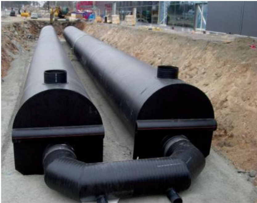
Figur 11. Exempelbild på parallellkopplat rörmagasin från Växjö (Uponor).
