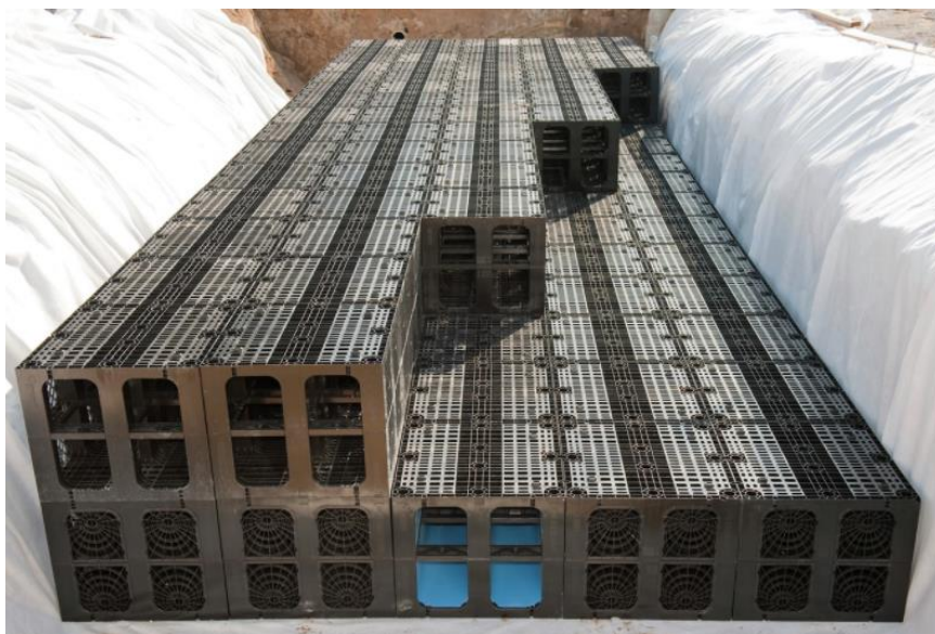
Figur 10. Exempelbild på dagvattenkassetter och dess konstruktion.
