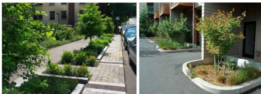
Figur 11.1. Exempel på nedsänkta växtbäddar. Vänster foto: City of Portland, Courtesy Bureau of Environmental Services. Höger foto: Dagvattengruppen, Sweco
