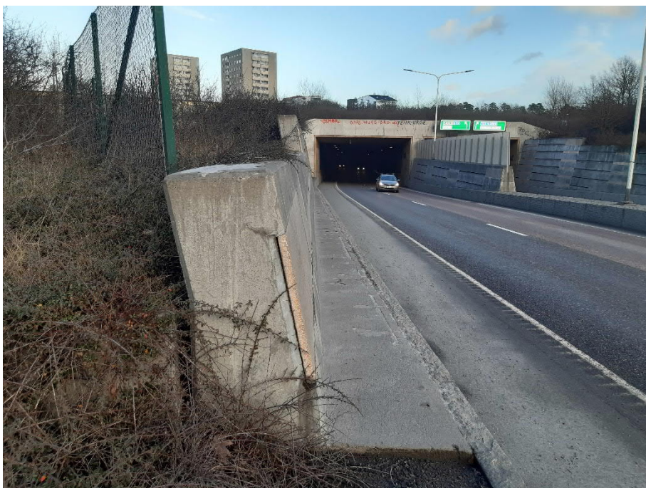
Figur 4. Stödmur, gatubild från sydöst mot Södra länken-utfarten (2020).
