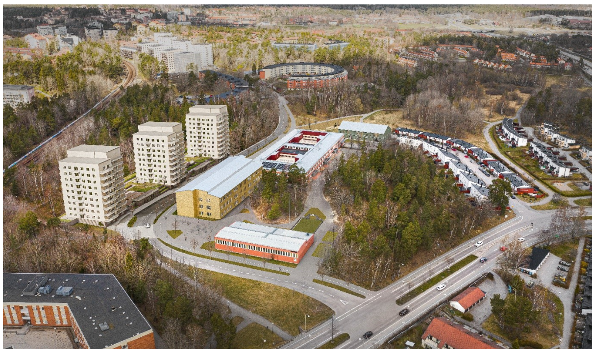
Flygfoto med befintlig och planerad bebyggelse. Bild: PE Arkitektur & Teknik
