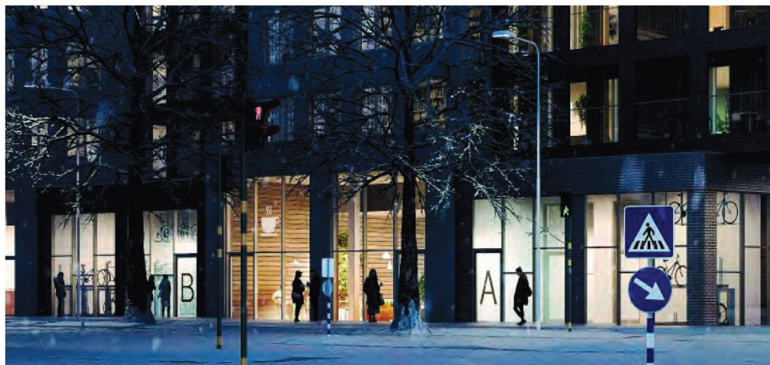
Figur 47. Exempel från kvalitetsprogrammet i etapp 2 kv B. Cykelparkering i entréplan i direkt anslutning till trapphus och som en tydlig del av gatubilden.
