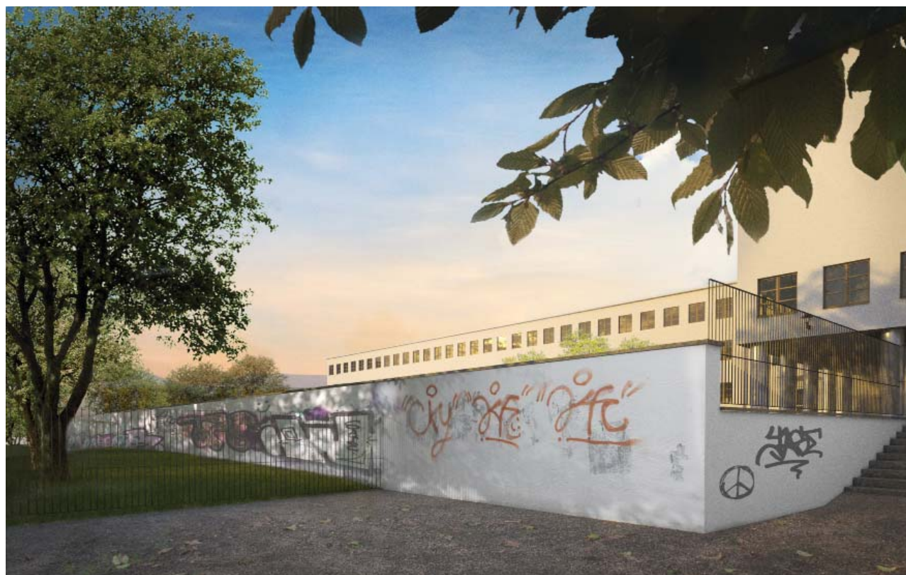
Mur mot Tjurbergsparken i öster, före
