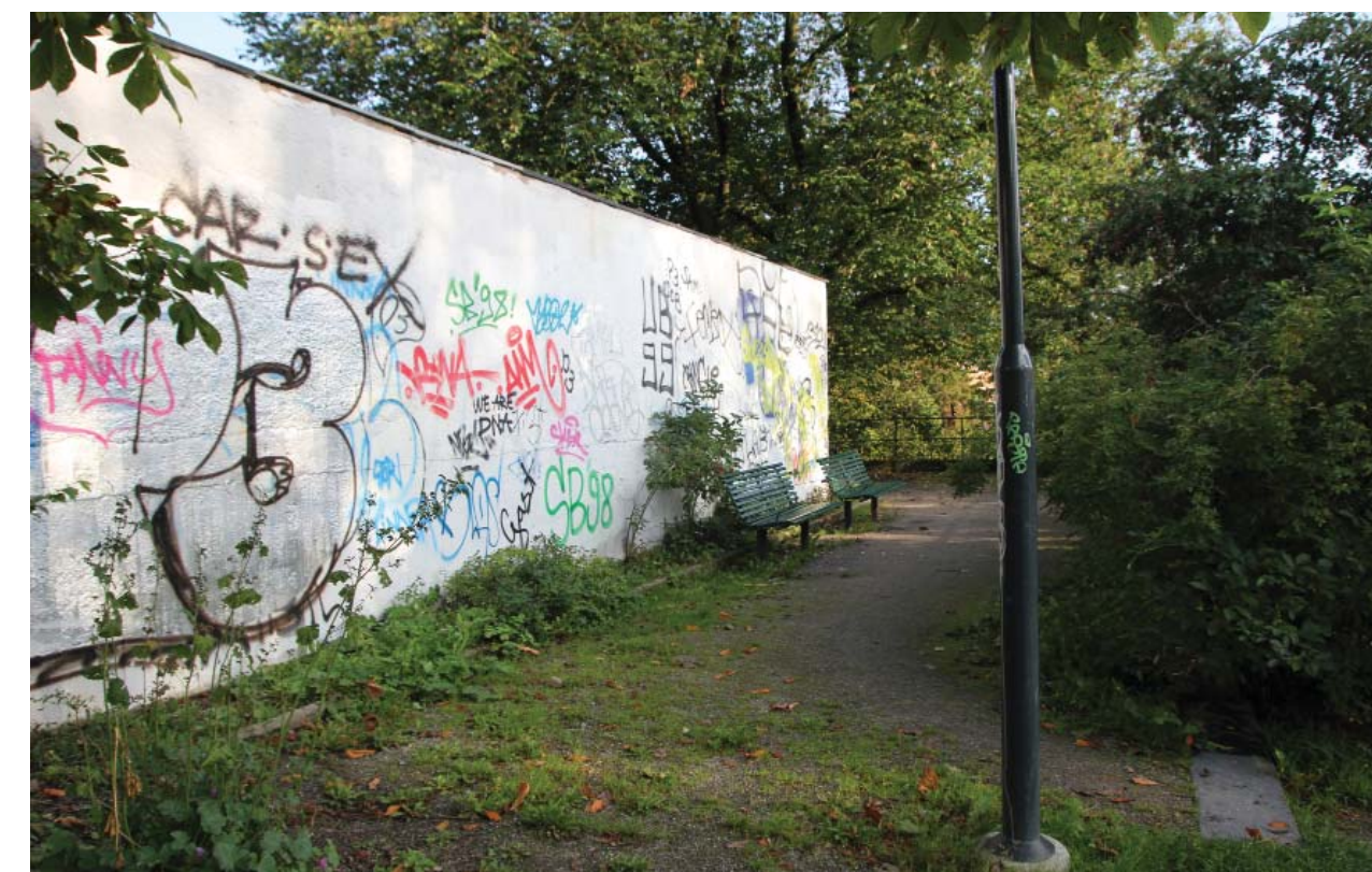
Mur mot Tjurbergsparken i väster vid "Båten" vid ny entré till lokaler, före
