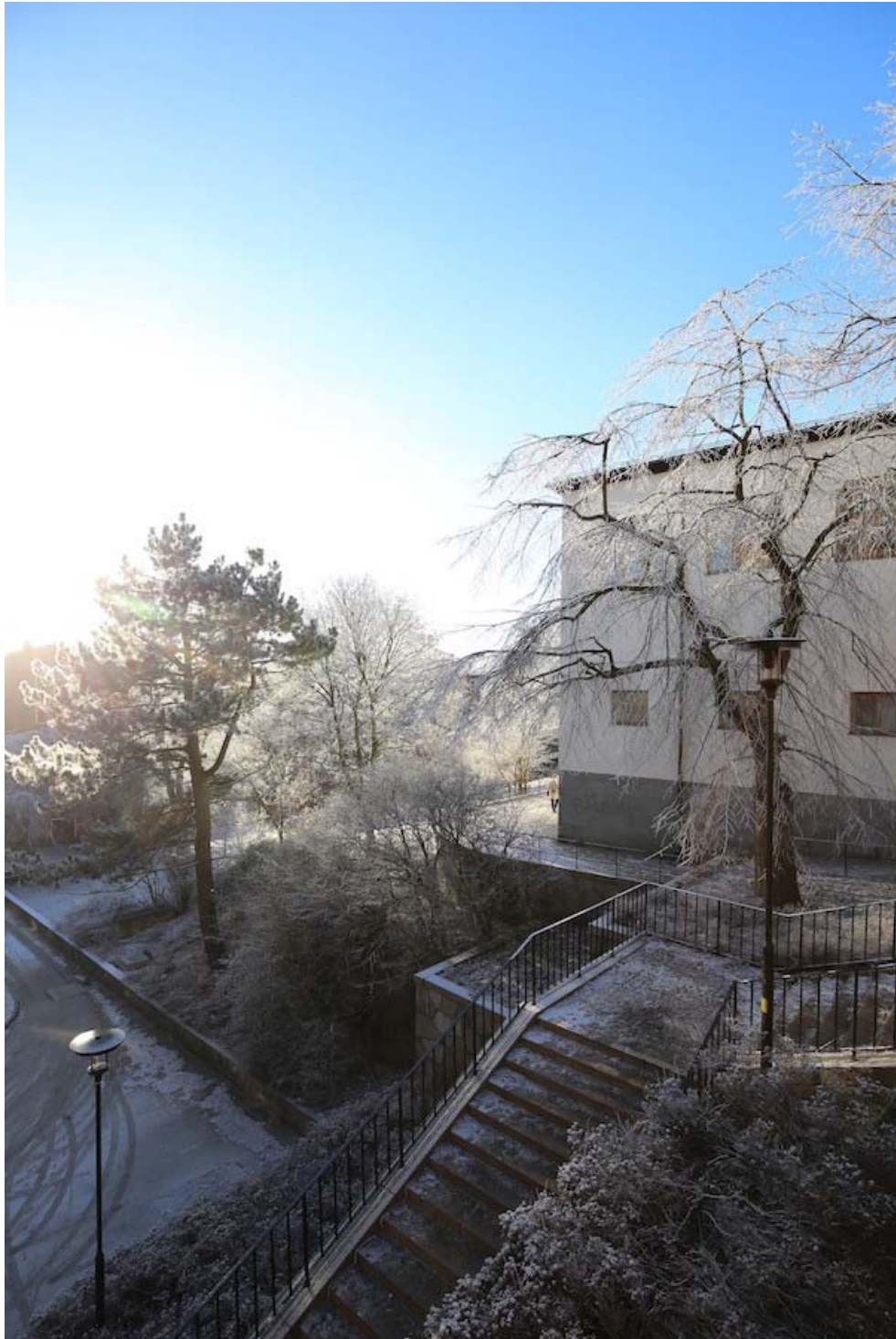
Vy från Älvsborgsgatan, över det kraftfulla trappsystemet av natursten, mot gymnastiksalens sydöstra hörn. Utmed gymnastiksalens gavel fungerar den stensatta ytan till en solbelyst terrass.
