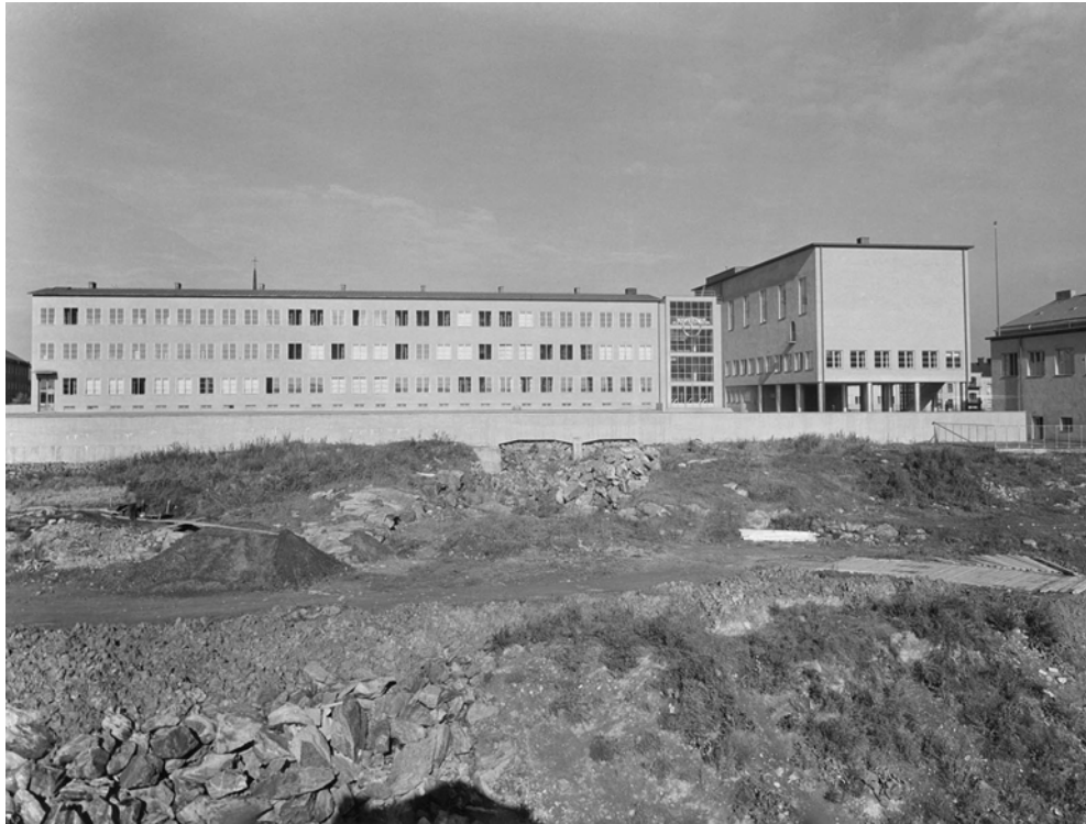
Katarina realskola när den var alldeles nyligen färdigställd. Utanför skolgårdsmuren ligger Tjurberget fortfarande i dagen. Närmast i bild ligger sprängsten, troligtvis rester efter skolbygget Källa: ArkDes.
