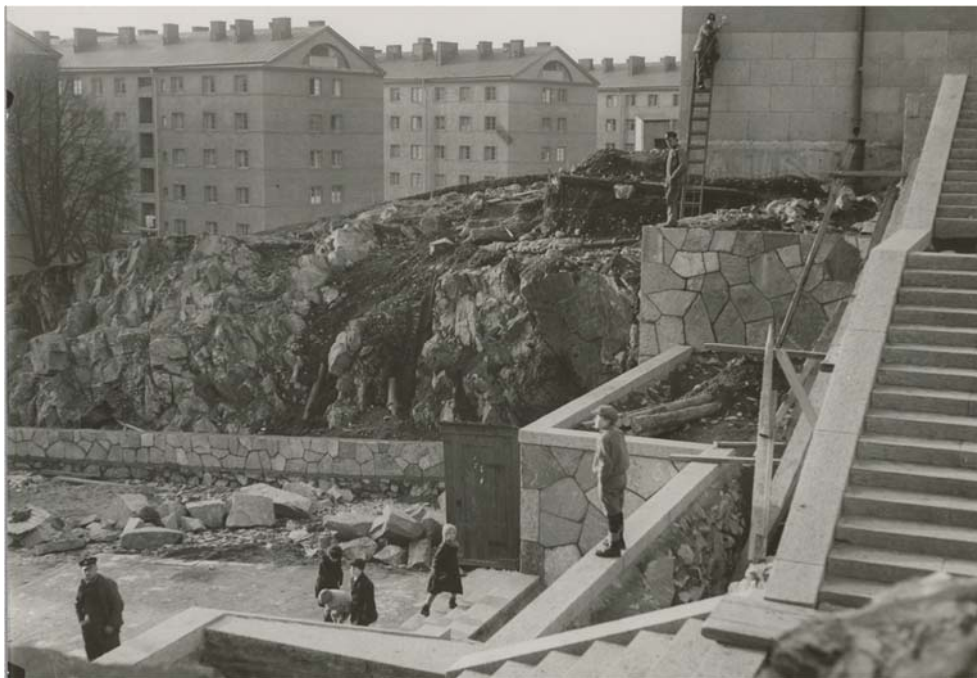
Anläggandet av trappor och terrasseringar öster om Katarina Realskola. Årtal okänt men fotot bör vara taget under 1930-talets första hälft och ännu har denna del av parken inte färdigställts. Källa: Stockholms stadsmuseum.
