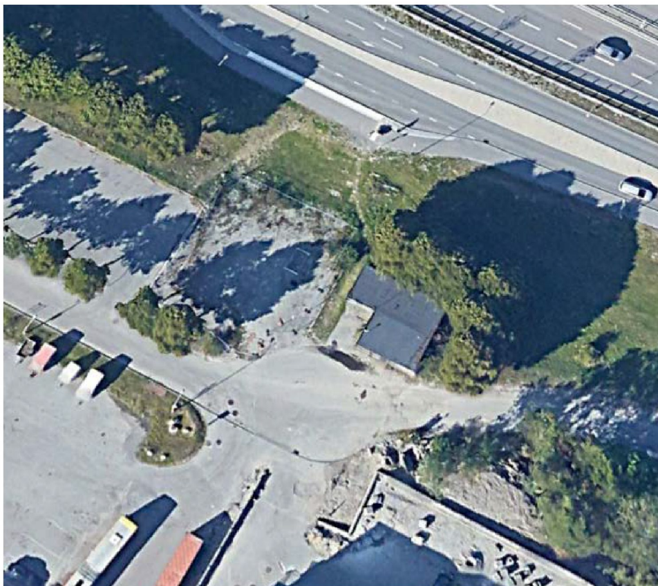
Fastighet Köping 2 (Källa: google earth)
