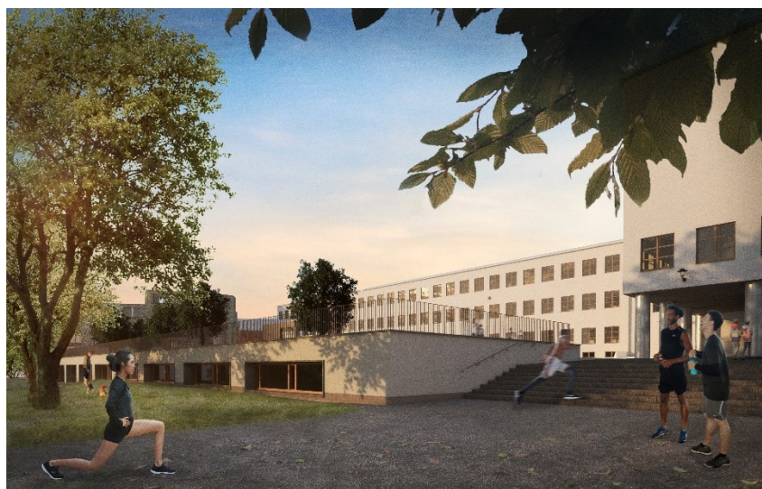
Figur 32. Vy vid den nya trappan. Till höger syns den nya murfasaden och till vänster skolans upphöjda aula. Bild: Erséus arkitekter
