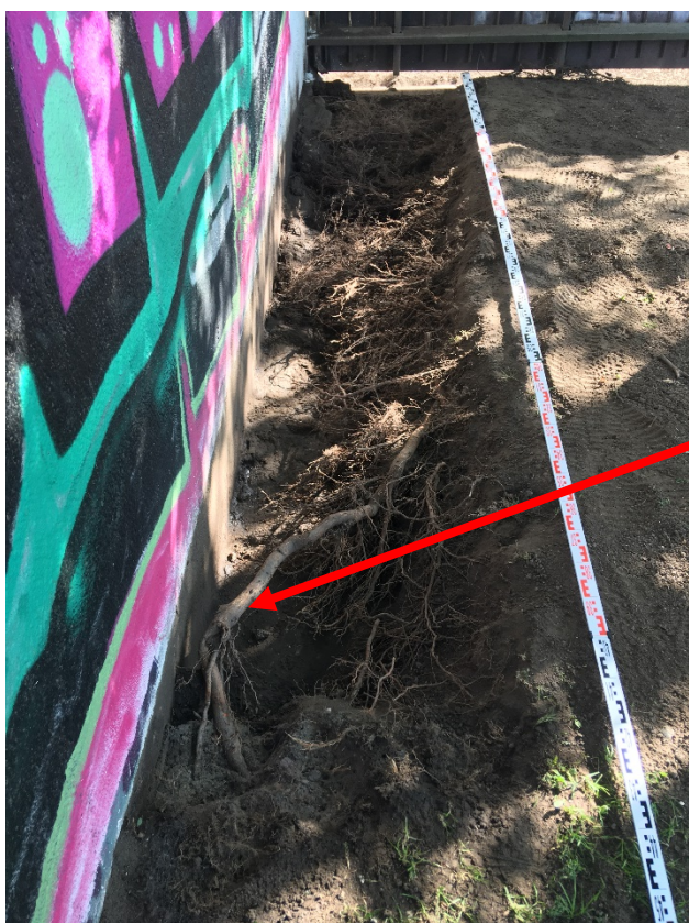
Bild 5 En rot med diameter 4 cm intill muren
