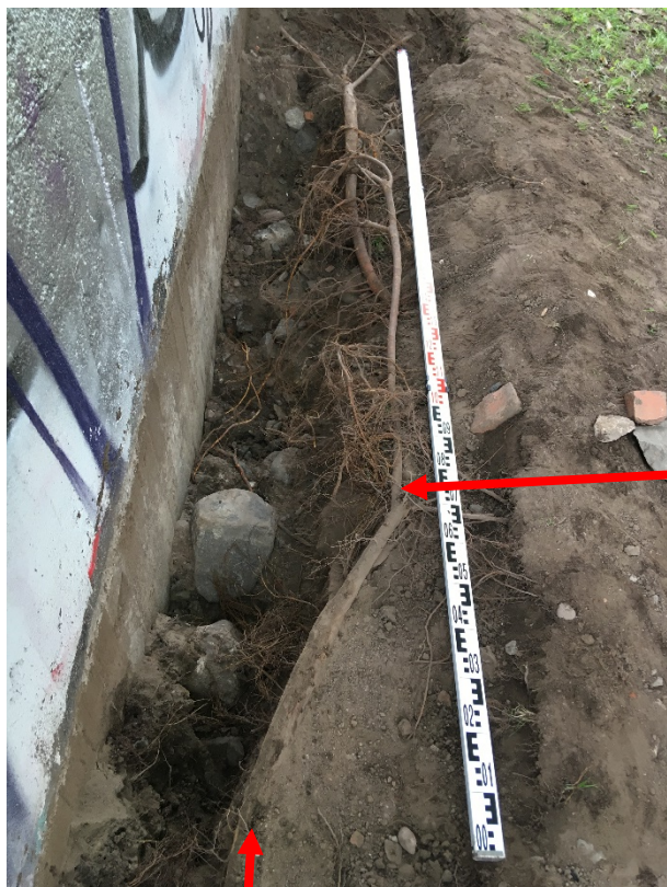
Bild 23 En rot växer parallellt med muren
