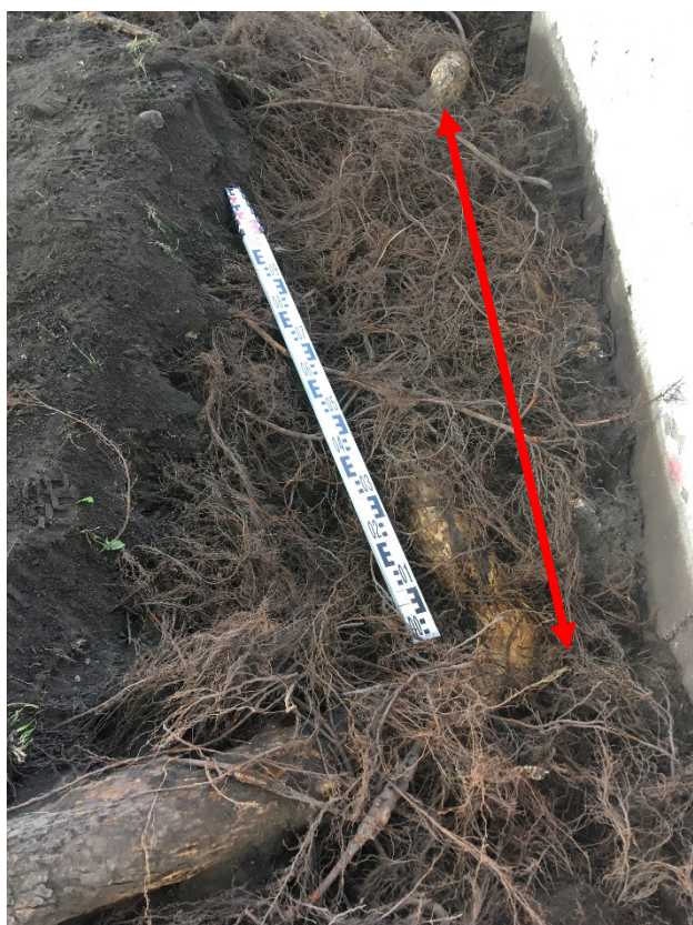
Bild 12 En av de stora rötterna växer parallellt med muren
