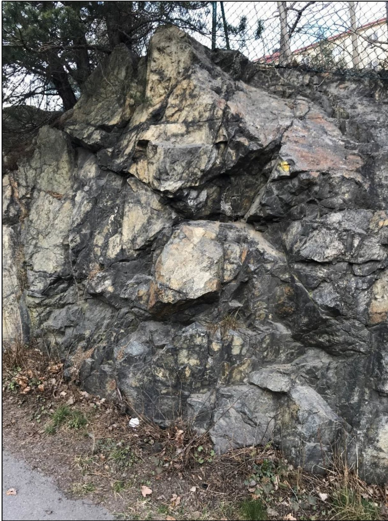
Figur 4. Befintlig bergskärning i läget för hus C. I huvudsak storblockigt berg, med inslag av mer uppsprucket berg.
