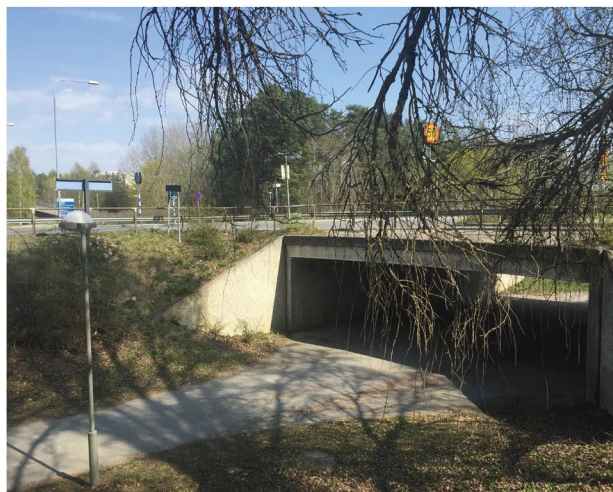
Foto 3: Befintlig gångtunnel under Sveaborgsgatan.
