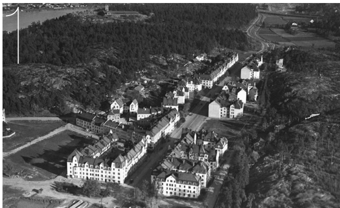
1. Flygbild över Aspudden mot öster, ca 1935. Fotograf O. Bladh. Källa: Digitala Stadsmuseet
