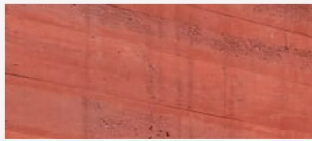
Betong med ingjuten relief
