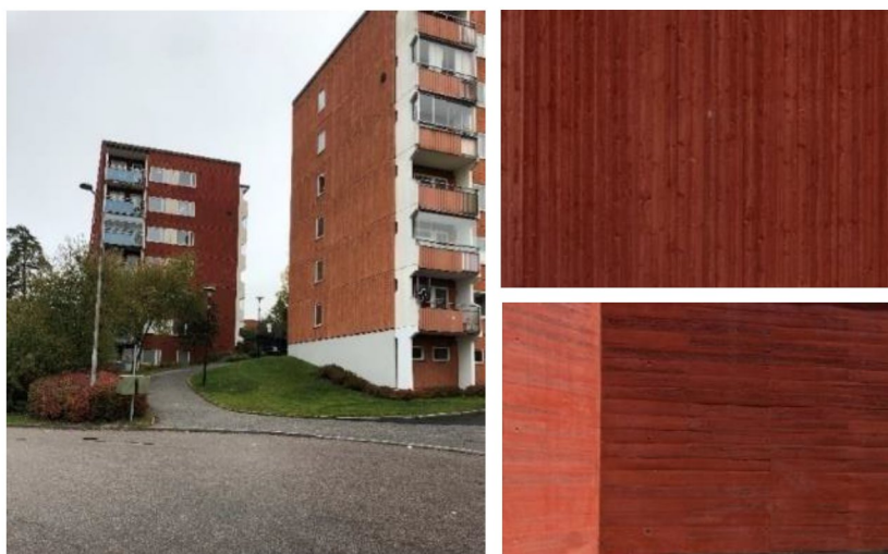
Exempel på omgivningens putsade fasader i mättade kulörer, Husby Höger sida överst: Exempelutformning på ny bebyggelse, målad träpanel. Höger sida nederst: Exempelutformning på ny bebyggelse, Infärgad betong
