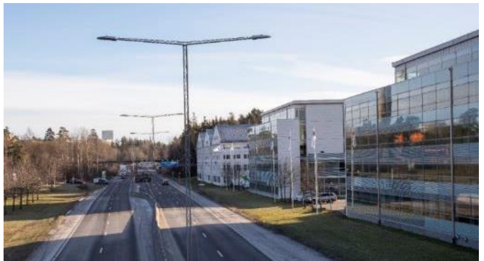
Foto från Vandagatans gångbro. Vy över kontorsbyggnaderna längs Hanstavägen.
