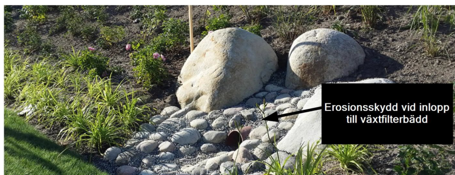
Figur 15. Exempel erosionsskydd vid inlopp infiltrationsyta. 17
