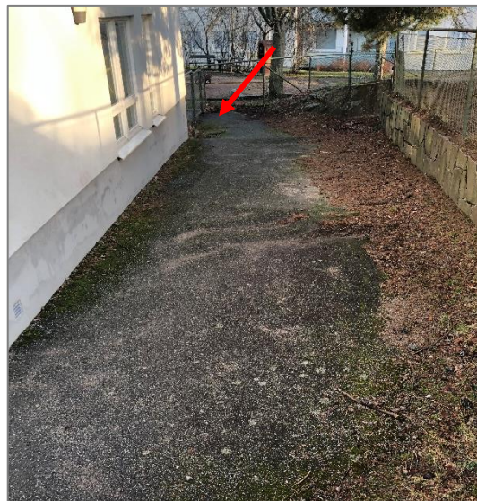
Figur 2-7. En dagvattenbrunn strax öster om planområdet. Brunnens placering är märkt med röd pil.
