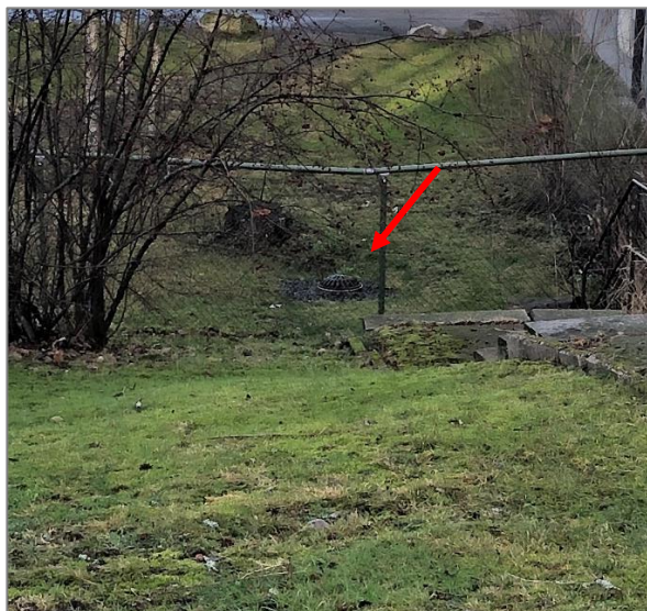
Figur 2-6. En kupolbrunn i en lågpunkt öster om planområdet. Brunnens placering är märkt med röd pil.
