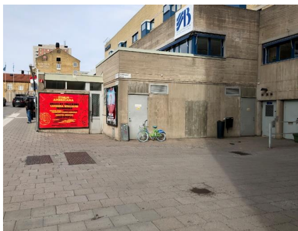
Figur 17 Portarna i södra delen av fastigheten ligger i en lågpunkt och dagvatten riskerar att ansamlas här och ledas in i byggnaden
