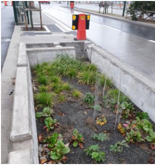
Figur 27 Regnbädd längs Neptunigatan i Malmö. Översilningsdjup ca 50 - 60 cm
