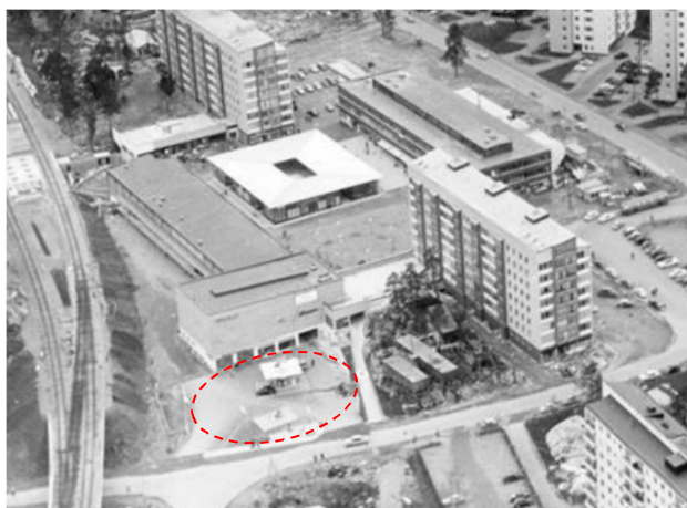
Figur 4. Historisk bild över Hagsätra centrum med tidigare bensinstation markerad.
