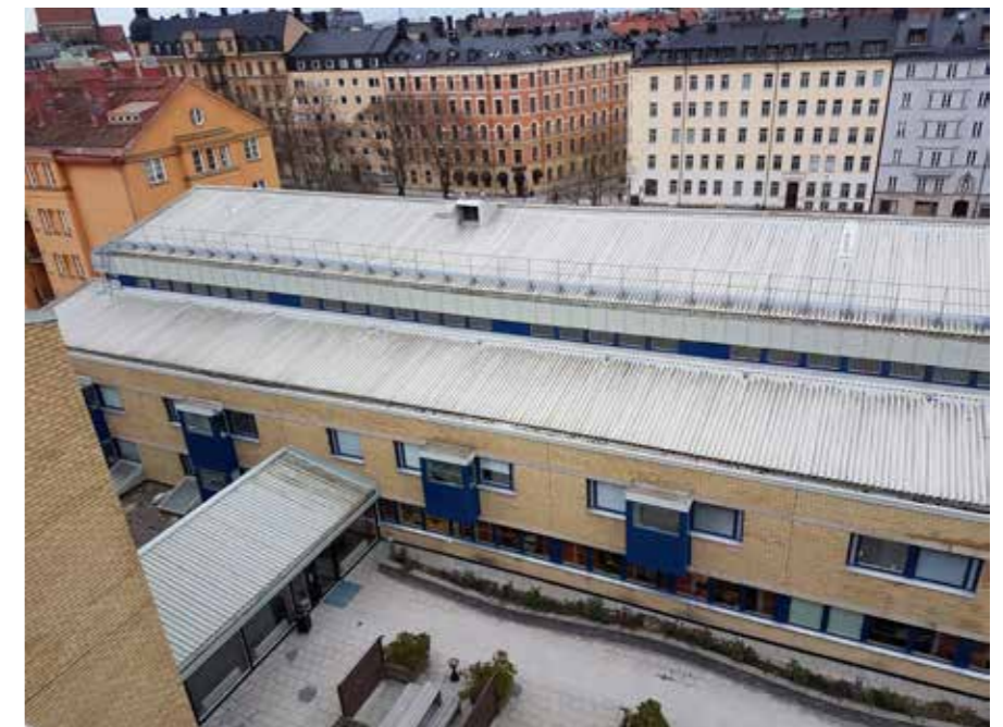
Taken är täckta med omålad korrugerad plåt.
