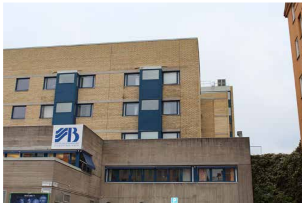
Foto mot nordost.
