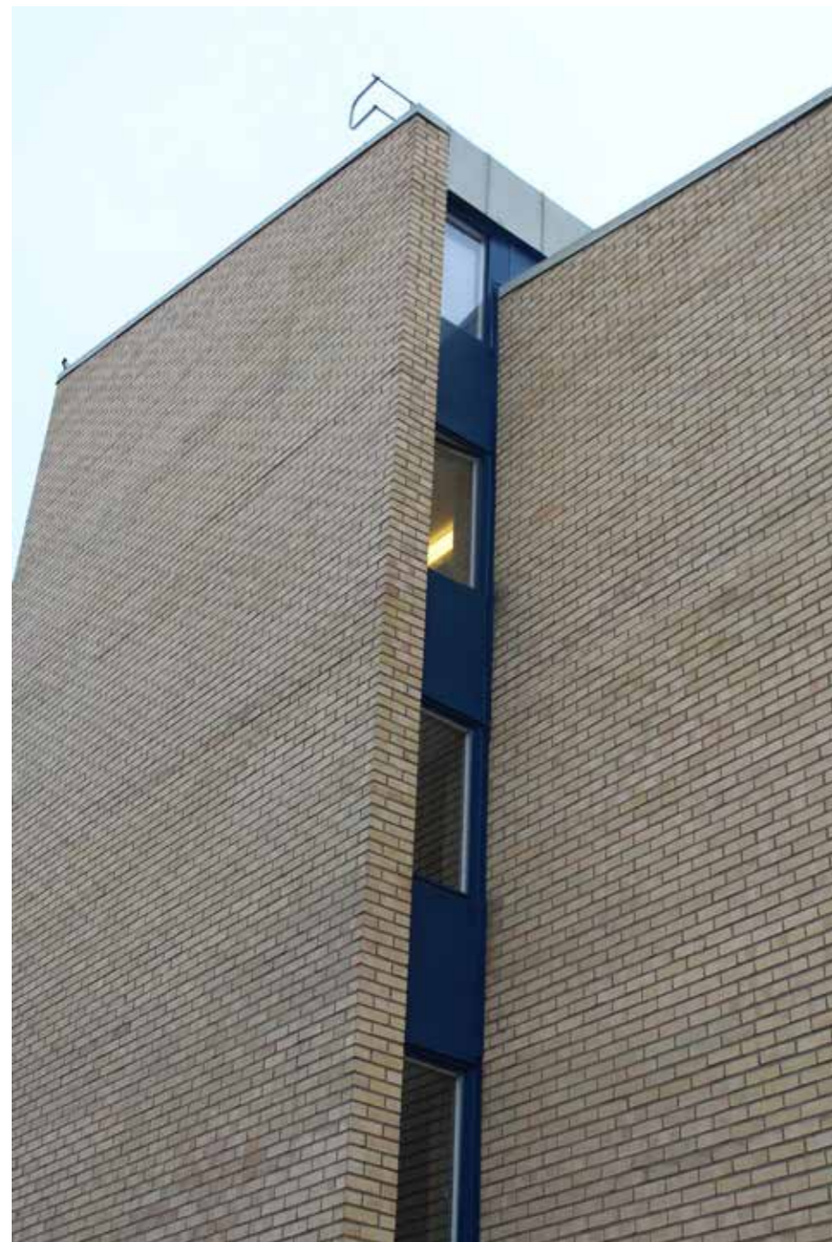
Mellan de distinkta byggnadsvolumerna finns vertikala fönsterpartier i blålackerade metallprofiler.
