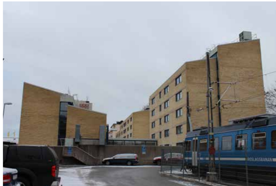
Från spårområdet i sydost ser man de karaktäristiska gavelpartierna. Denna del av anläggningen har i dagsläget i större utsträckning karaktär av baksida.
