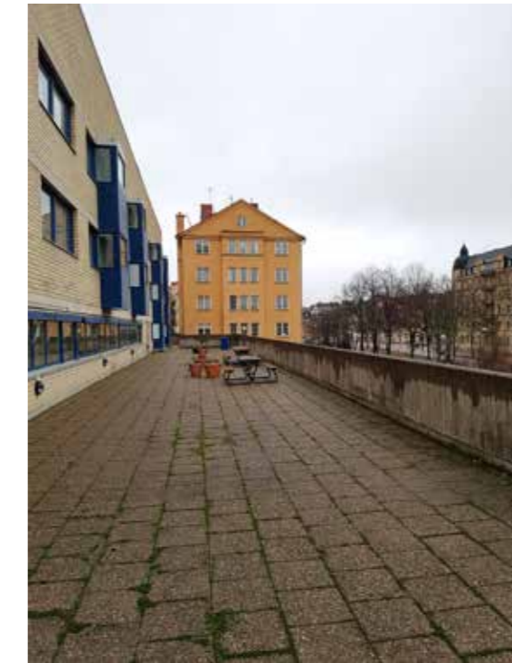
Befintligt terrass framför Hus B.
