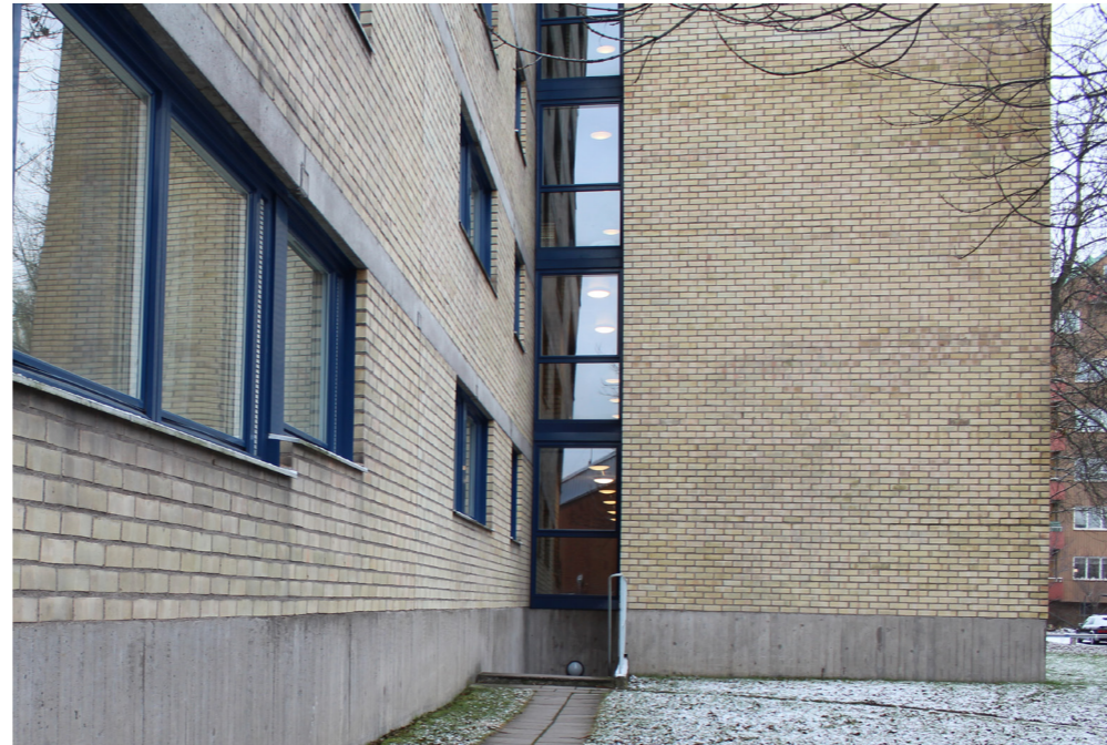
Mellan de distinkta byggnadsvolymerna finns glaspazier i blålackerade metallprofiler.
