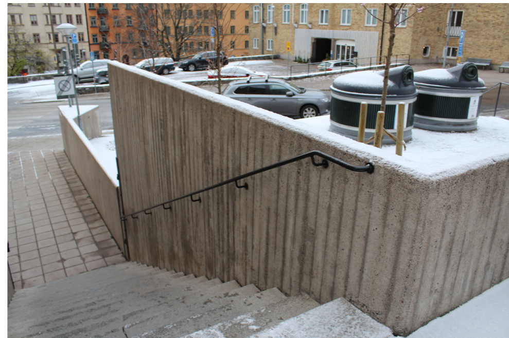
Stödmurar av betong är ett karakteristiskt inslag i anläggningen.
