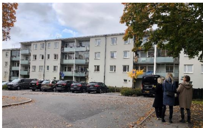
Foto som visar närliggande flerbostadshus. Fotot är taget från nordväst.
