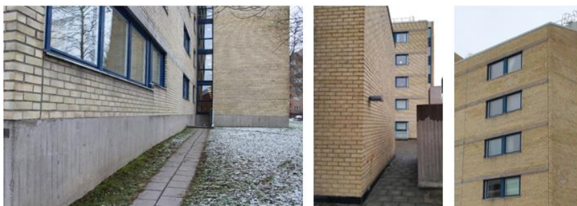
Exempel sockel i formgjuten betong, fasadtegel, synliga betongbalkar över fönster.
