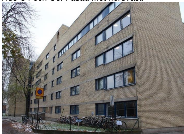
Bild 2 Exempel fasadutförande, fönstersättning och fönster. Hus C4 och C3. Fasad mot nordost.
