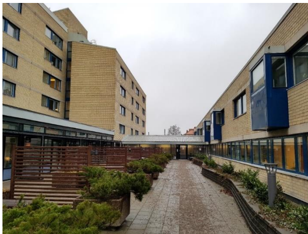
Bild 4 Exempel fasad och fönstersättning och burspråk. Hus C2, C1, B2. Vy mot sydost.
