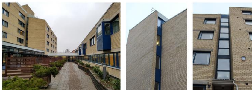
Exempel burspråk, förskjutna volymer, slits/ljusinsläpp mellan volymer, trapphus, blå profiler.
