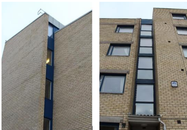
Bild 5 Exempel förskjutna volymer, slits/ljusinsläpp mellan volymer. Trapphus. Blå profiler. Hus C4/C3.
