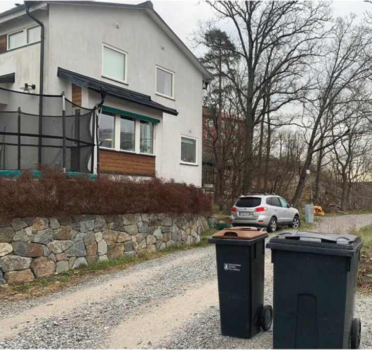
6. Bef. byggnad på grannfastigheten
