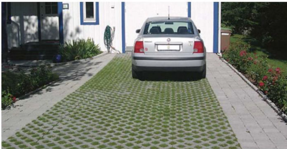
Figur 7-10. Parkering med permeabel yta.
