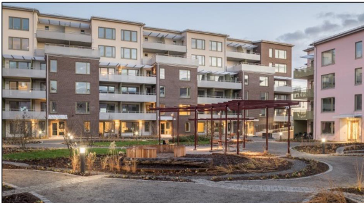
Figur 7-1. Avledning av takvatten till planteringar via ränndalar anlagda i gatsten. Exempelbild från Linnéhuset i Uppsala (Källa: Uppsalahem).
