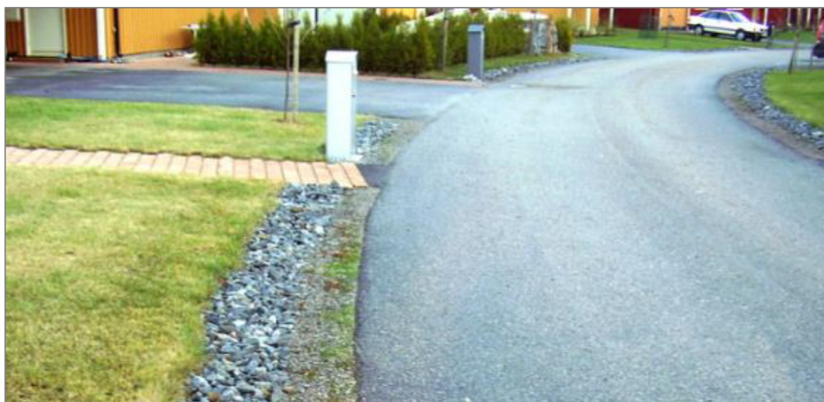
Figur 7-5. Till vänster om vägen finns ett underliggande makadamdike. I det översta lagret blandas mindre fraktioner makadam med jord och i botten placeras grövre makadamfraktioner.
