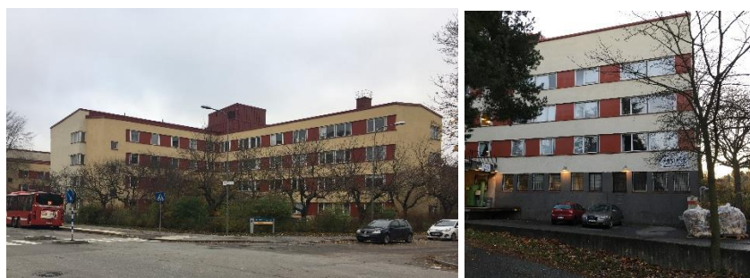
Figur 16. Den befintliga byggnaden på fastigheten
