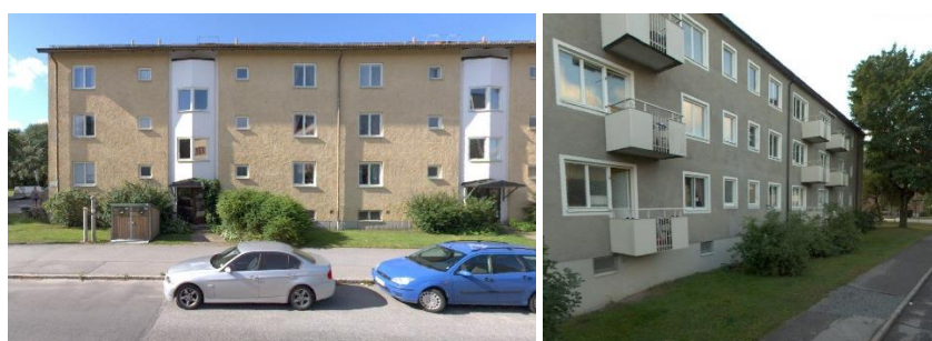
Figur 14. T.v. Lamellhusen på andra sidan Årstavägen. T.h. Lamellhusen på andra sidan Ottsjövägen.
