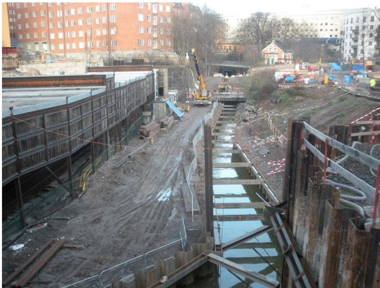
Figur 11 - Bild från anläggandet av Citybanan som visar det högt stående grundvattnet i Fatbursparken (bild: Göran Johnson).
