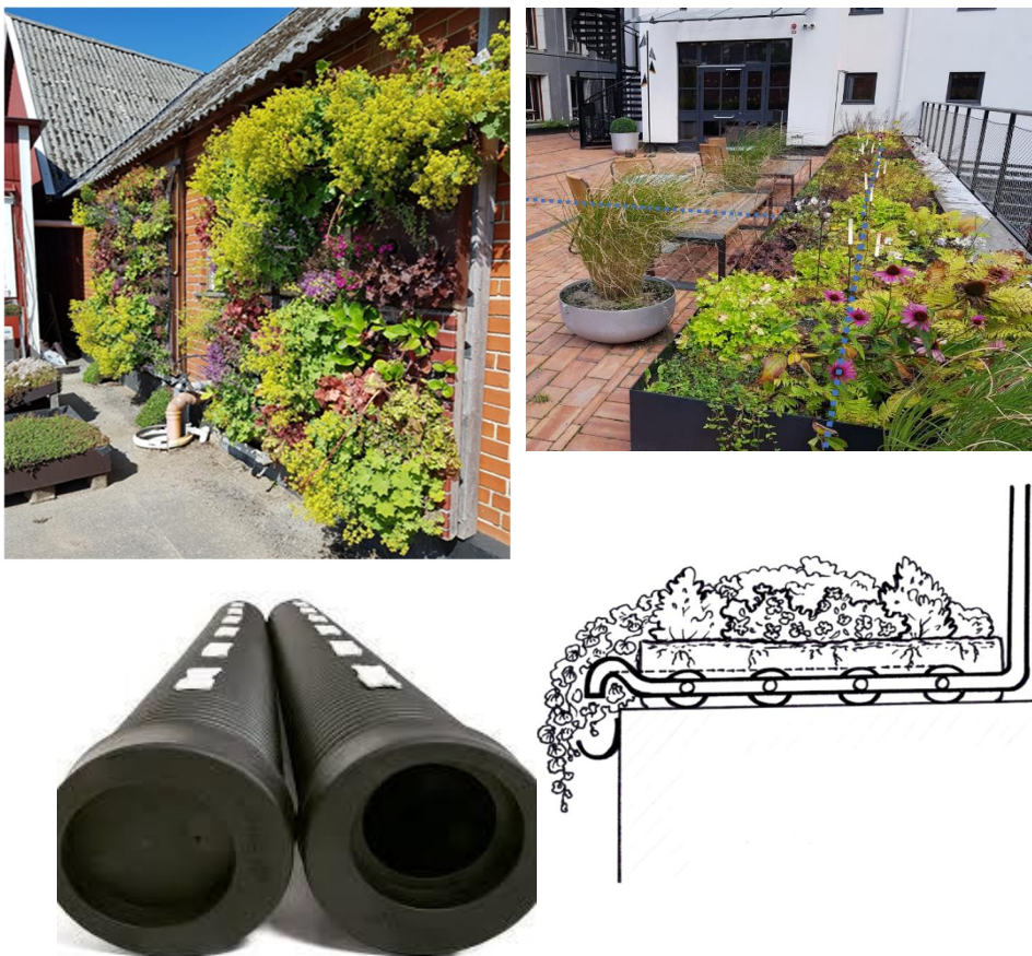
Figur 20 - Uppe till vänster: Bevattningsystem för väggperenner (bild:Sweco). Uppe till höger: Blique by Nobis, Blå streckad linje under plantering är tex. ett Savaq-system (bild: Sweco). Nere till vänster: Savaq-system (Terregio.se) Bevattningsystem som utnyttjar kapillarkrafterna. Nere till höger: Princip bevattningsystem under upphöjd plantering (Terregio.se).
