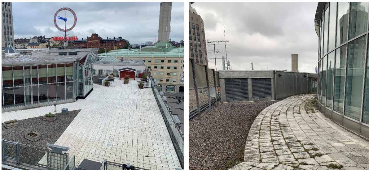
Figur 4 - Takens utformning, Saluhallshuset till vänster och Björkhallshuset till höger (bilder: Sweco).
