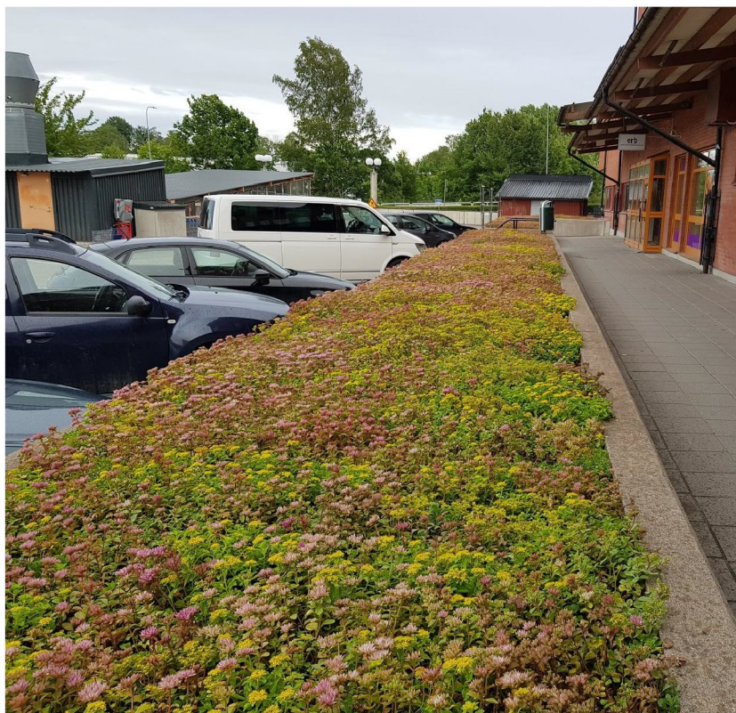
Figur 22 - Ekerö Centrum, garagebjälklagstak. Sedummatte, standard/original, tjocklek 30mm (bild: Sweco).
