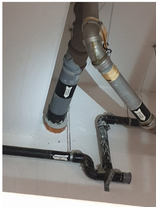
Bild 2. Utgående dagvatten Björkhallshuset
