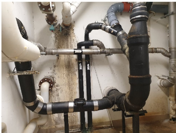
Bild 7. Utgående dag-/ och spillvatten samt inkommande kallvatten Söderhallshuset, sprinkler kapacitetsprovledning, spillvatten till pumpgrop samt luftningsledning från pumpgrop.
