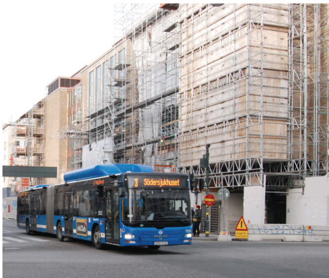
Renoveringsarbetena vid Medborgarhuset
