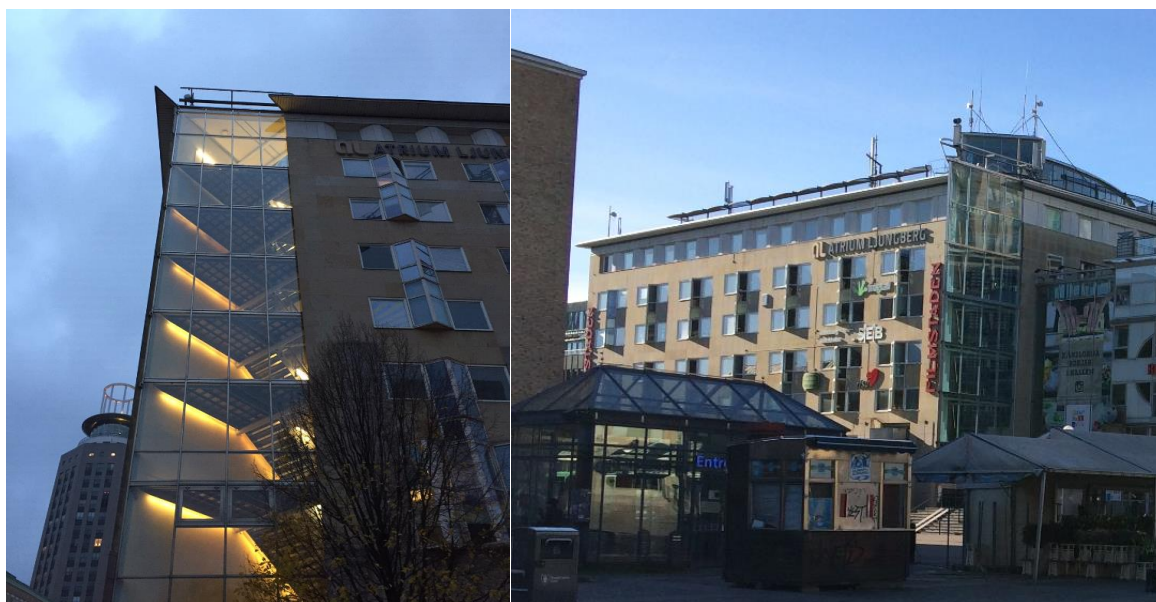
Björkhallens fasad: Fönstren veckas ut i ett litet burspråk som ger djupverkan och släppljus över fasaden. Takfoten är markerad, men bryts av vid de glasade partierna som ger ett diagonalt snitt genom byggnaden och som ger dagsljus in i ljushallen.
