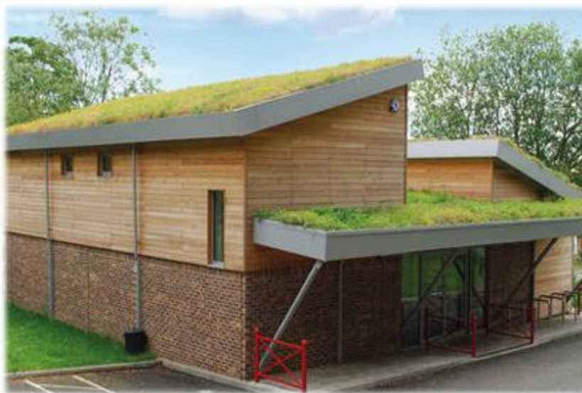
Figur 11.7. Extensivt grönt tak. Gröna tak kan anläggas på både platta och lutande underlag (Svenska Naturtak, 2016)
