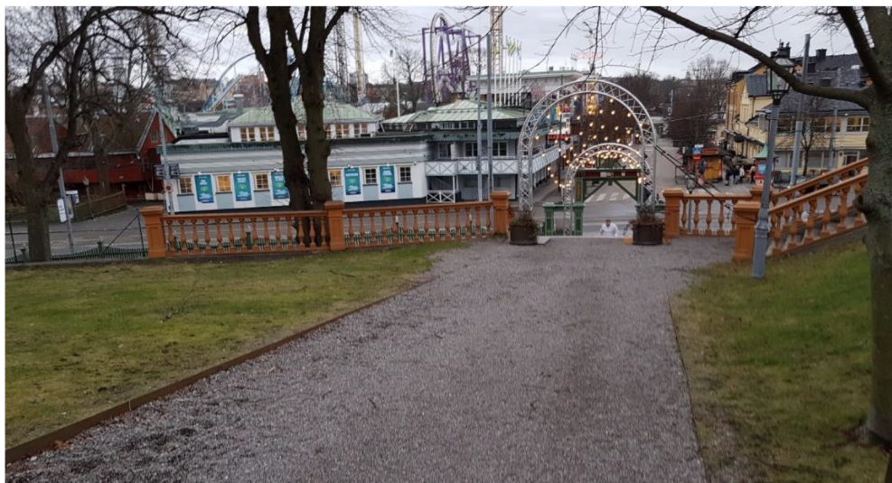
Figur 7. Foto från platsbesök 2020-02-10 som visar erosionsskador av grusgång där stora mängder grus transporteras på grund av avrinning längs med gångstråket ned mot Djurgårdsvägen.
