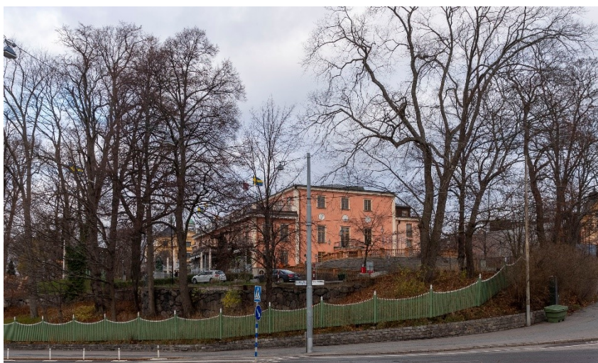
Huvudbyggnaden sedd från Djurgårdsvägen vid Hazeliusbacken.
