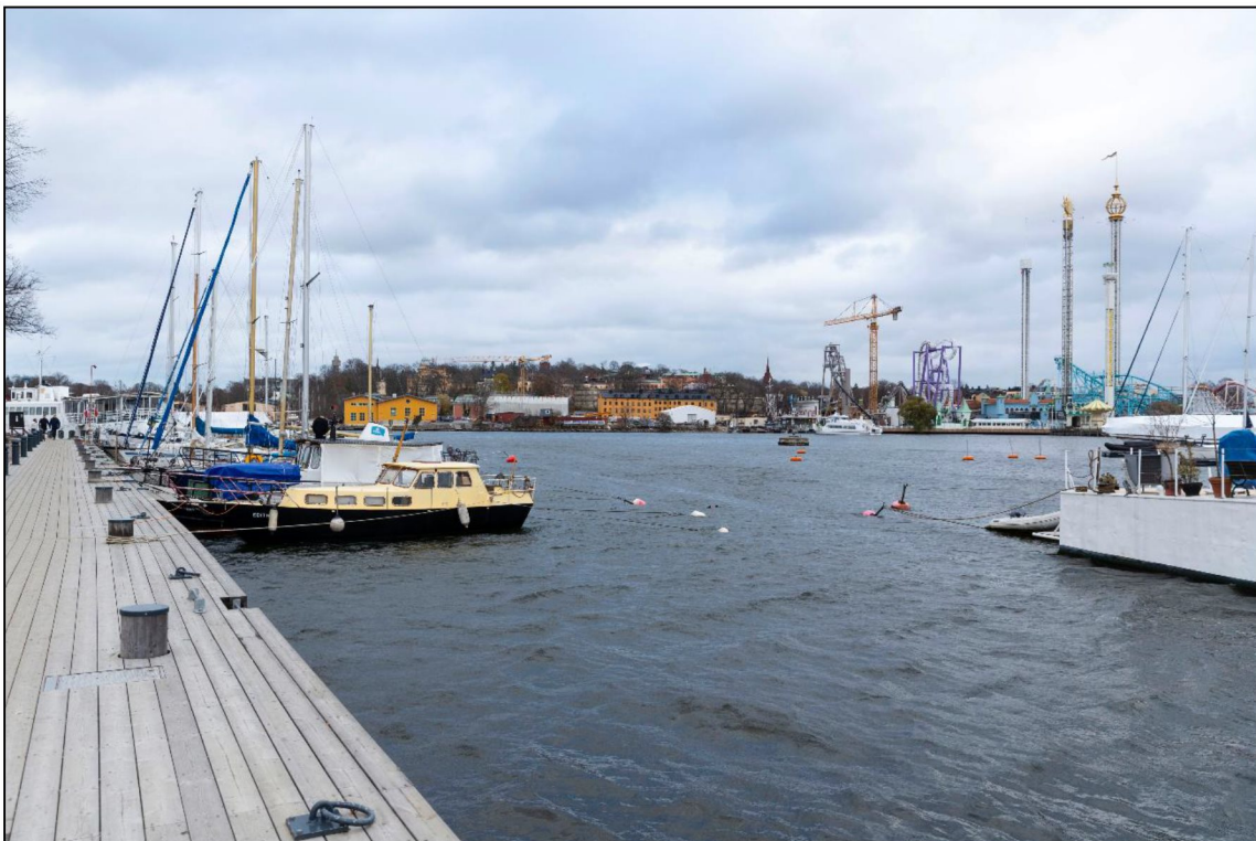
Figur 10. Vypunkt 1, vy från Skeppsholmen – Förslaget med fasad i trä.
