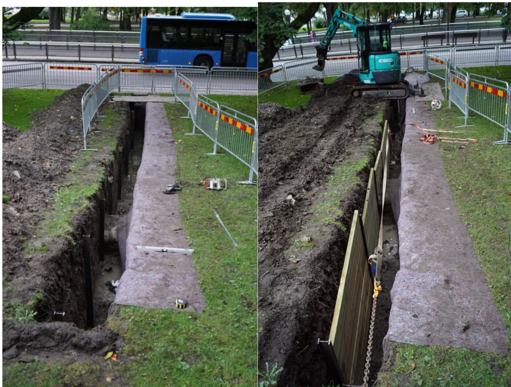
Bild 7. Utförande av skyddsspont steg för steg.
