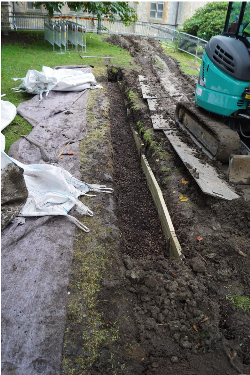
Bild 8. Fyllning mot skyddsspont med pimpstens.
